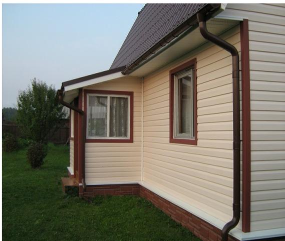
Облицовка на отnose (листовыми или погонажными материалами) - для такой облицовки на пенобетонную кладку надо закрепить подконструкцию - направляющие, к которым и будет непосредственно или через обрешетку крепиться облицовка, например, сайдинг, вагонка, металлические или керамические листы и т.д.
