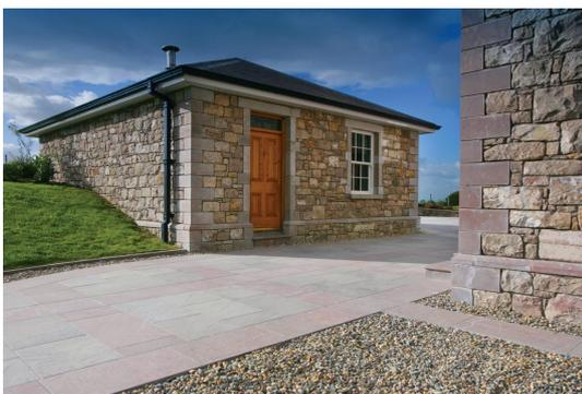
Облицовка бетонным сайдингом - данный вид отделочного камня специально адаптирован для отделки ячеистых бетонов. Сайдинг можно монтировать как на сухую, используя для крепления шурупы по дереву, так и с использованием клеящих составов, для придания большей жесткости и удобства монтажа. Между облицовкой и пенобетонной кладкой вентилируемый зазор при отделке фасада специально оставлять не нужно – он формируется
